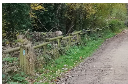
Exemple : Clôture asymétrique en rondins bois - Bassin de Trévoix
