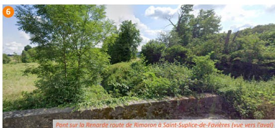
Pont sur la Renarde route de Rimoron à Saint-Sulpice-de-Favières (vue vers l'aval)
