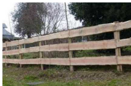
Exemple : Clôture en planches bois brutes issus de débitage sur site
