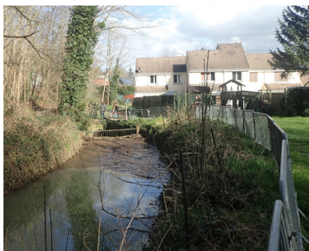
La mise en valeur inégale du cours d'eau
