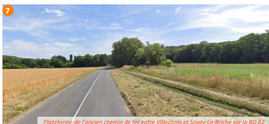
Plateforme de l'ancien chemin de fer entre Villeconin et Souzy-La-Briche sur la RD 82
