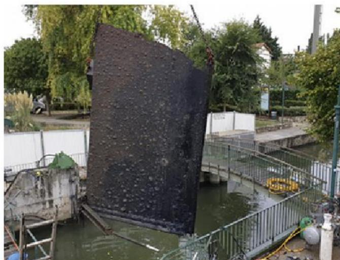
← Drakkar: levage par grue de la porte du clapet
