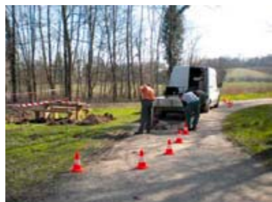
Réfection de pistes
