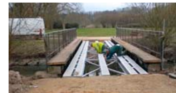
Réfection de la passerelle
