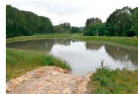
Ouvrage de dépollution naturelle
