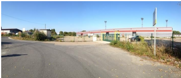
Zone industrielle des Cinquante Arpents
