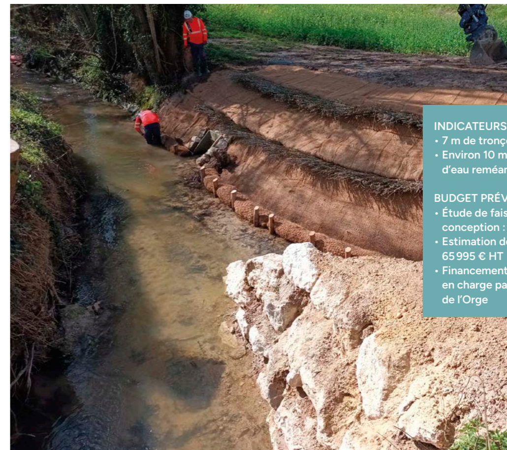
Opération de renaturation du Petit Muce avec la réouverture d'un tronçon busé afin d'améliorer le fonctionnement écologique du cours d'eau.
