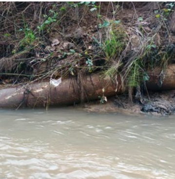
Casse du collecteur d’eaux usées à Limours liée à l’érosion des berges de la Prédecelle.
