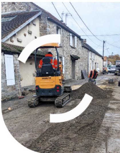
Remplacement d'un tronçon de 56 mètres en amiante-ciment par un collecteur d'eaux usées
