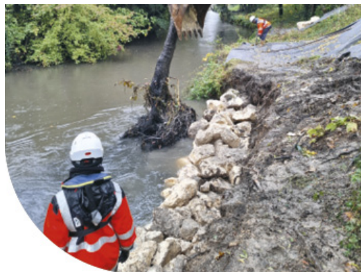
Travaux de nettoyage de la rivière avant la sécurisation d'une canalisation par pose de blocs de pierre.
