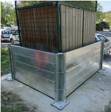
Installation de batardeaux contre le risque inondation
