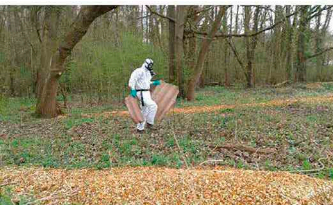
Ramassage d'amiante dans la vallée - Port des EPI obligatoire
