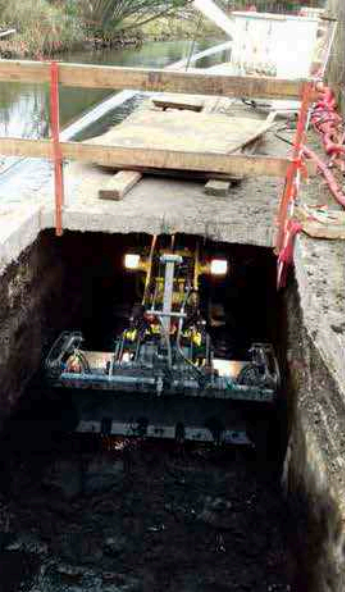
Travaux sur le CID
