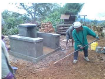
Construction de lavoirs, bornes fontaine et latrines avec des briques fabriquées sur place
