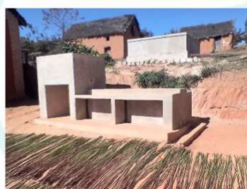
Construction de lavoirs, bornes fontaine et latrines avec des briques fabriquées sur place
