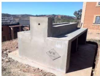
Construction de lavoirs, bornes fontaine et latrines avec des briques fabriquées sur place
