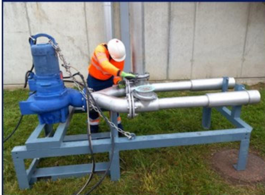
STEU Etréchy : Mise en place du système d'aération secours
