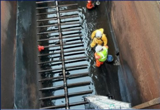
STEU Morigny-Champigny : Renouvellement de l'agitateur du bassin d'aération
