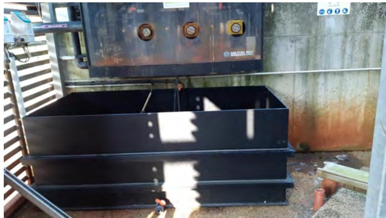
Le débitmètre comptabilisant le volume de chlorure ferrique injecté dans le bassin d'aération B a été remplacé suite à une défectuosité de l'ancien.
