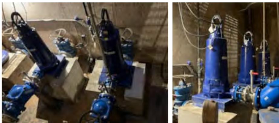
Bassin d'aération : Remplacement de l'agitateur du bassin A
