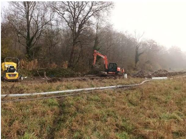
Des travaux d'urgence ont donc été entrepris sur un tronçon de 35 ml Ø300. Pendant les travaux, un refoulement a été mis en place pour stopper le déversement des eaux usées au milieu naturel.
