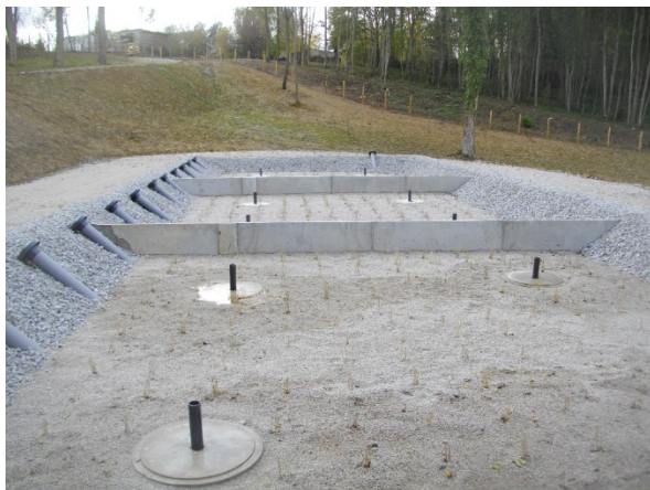
Filtres plantés de roseaux en phase travaux
