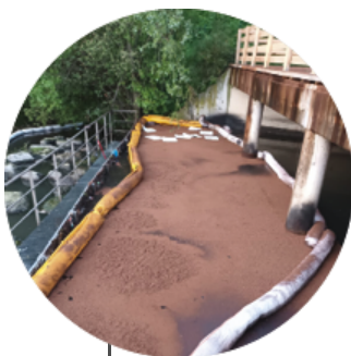
Poudre absorbante d'hydrocarbures en sortie d'ouvrage d'eaux pluviales
