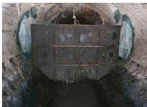
Batardeau temporaire d'obturation de la canalisation d'eaux usées
