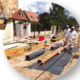
Le polypropylène a remplacé l'amiante-ciment sur le réseau d'eaux usées de La Ville du Bois.
