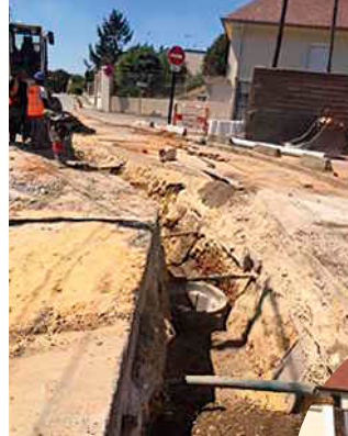
Le polypropylène a remplacé l'amiante-ciment sur le réseau d'eaux usées de La Ville du Bois.
