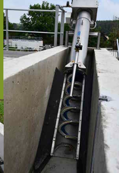
Élimination des déchets solides grâce à la vis d'évacuation
