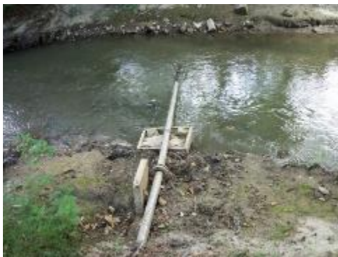
Figure 5 – Pompage Syndicat de l'Orge, adapté à la baisse du niveau d'eau
