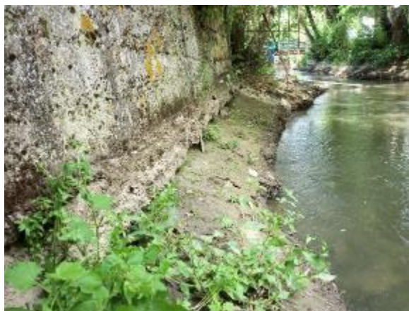
Figure 69 – Sous-cavement de mur observé en rive gauche.
