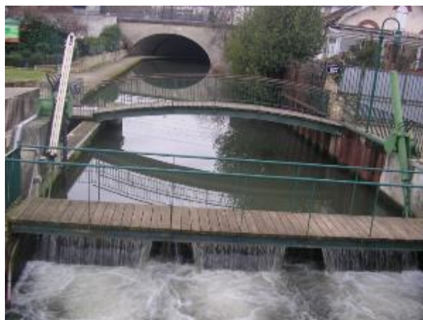
Figure 59 – Vue du clapet en position levée en 2007
