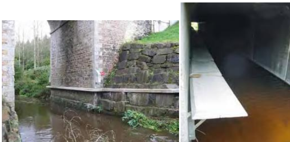
Figure 18 – Exemple de réalisation envisageable sous le pont (Source : Guide de mise en œuvre de la continuité écologique sur les cours d'eau ; AELB, fédération de pêche 29)
