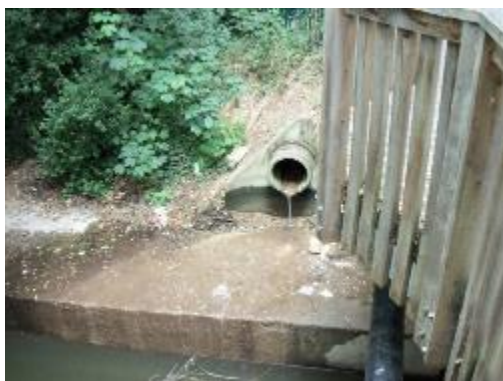
Figure 83 – Rejet par temps secs s'écoulant directement dans l'Orge.
