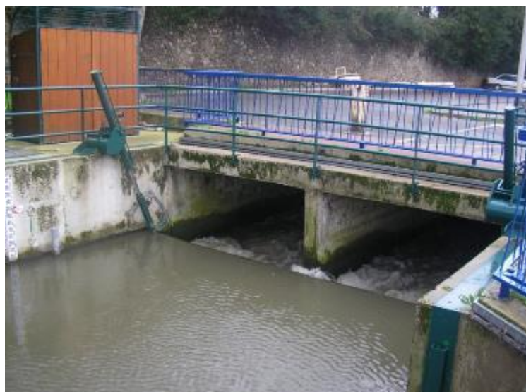
Figure 42 – Vue du clapet relevé en 2007
