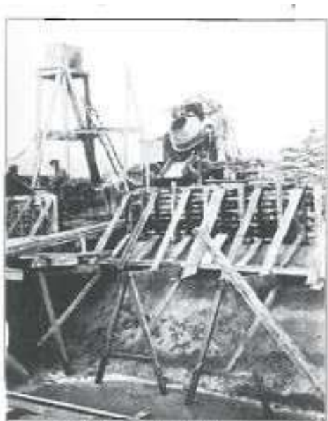
114 - 1930- Montage des échafaudages nécessaires et construction du mur de béton pour canaliser la rivière. (Doc. E. Fanchon)
