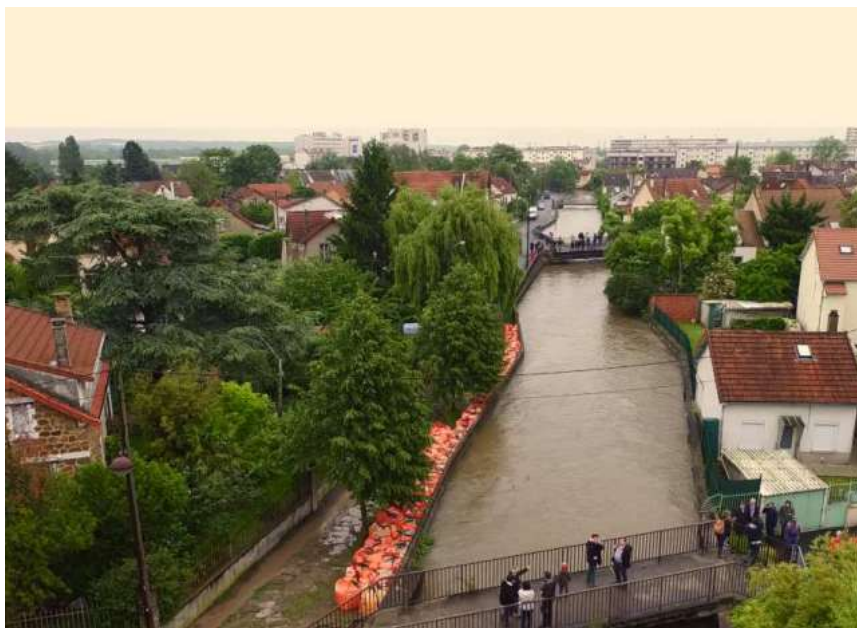
Confortement de la Morte Rivière par des bigbags - rue du Pont Godeau, Viry-Chatillon - 02/06/2016
