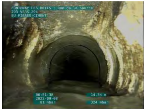
EU 289 vers 291 : Rue de la Source Concrétions et réduction de section
