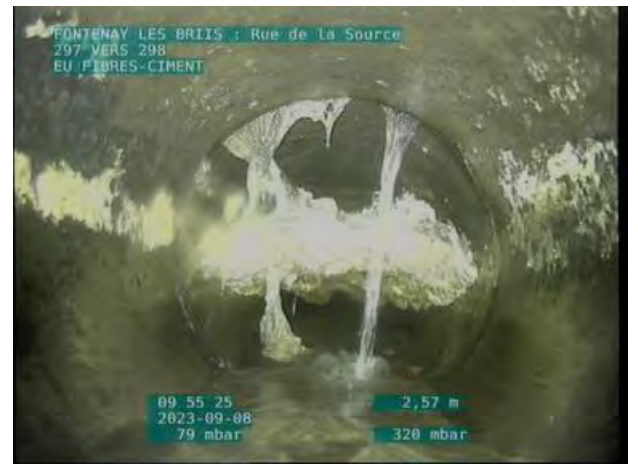
EU 297 vers EU 298 : Rue de la Source Infiltration par écoulement continu
