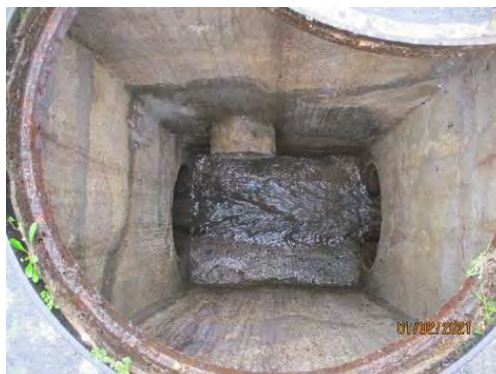
Figure 34 : Vue de l'arrivée du trop-plein dans le regard FLB-EP-55
