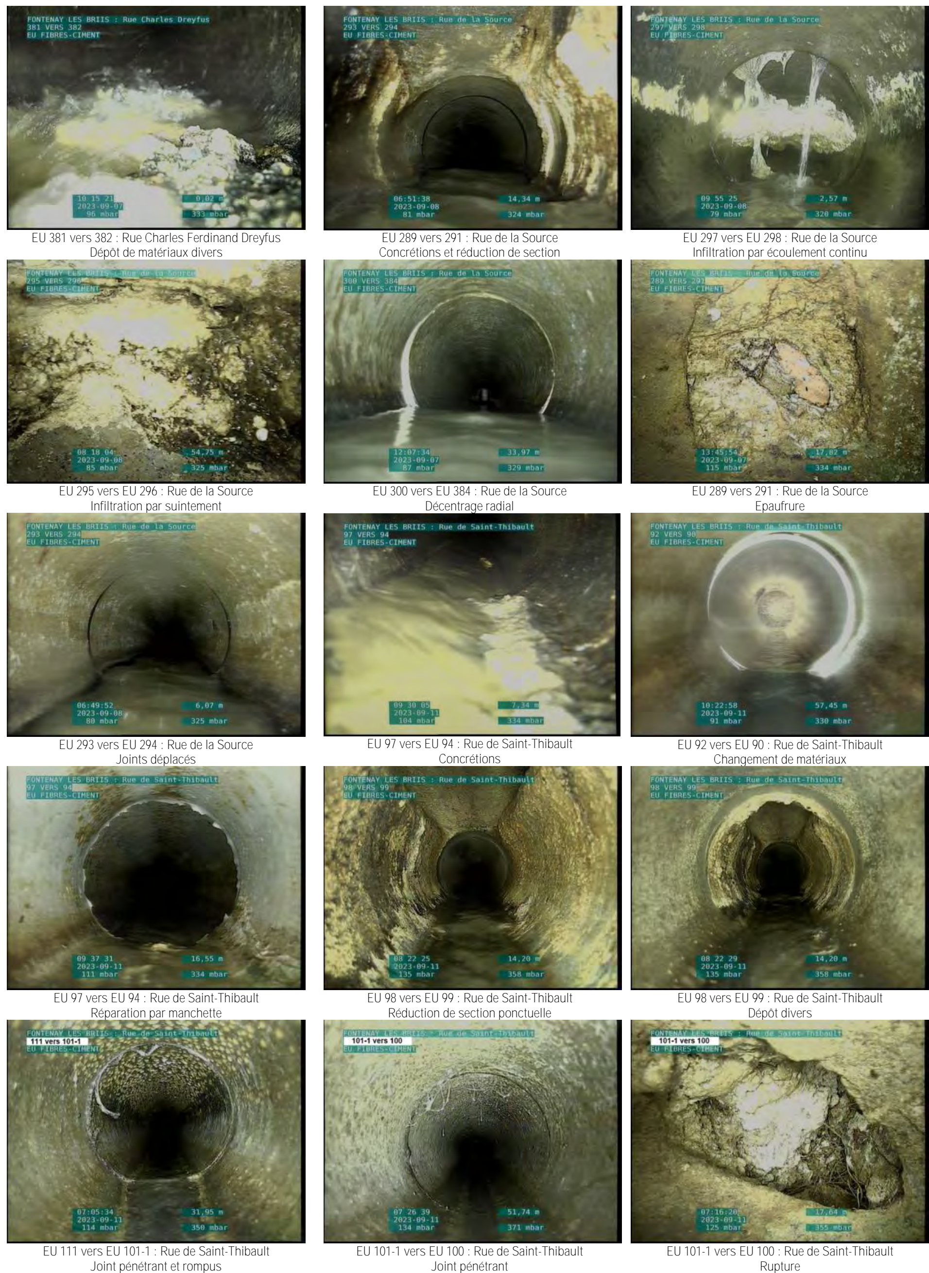
Figure 3 : Planche photographique des inspections télévisées réalisées sur la commune de Fontenay-Lès-Briis
