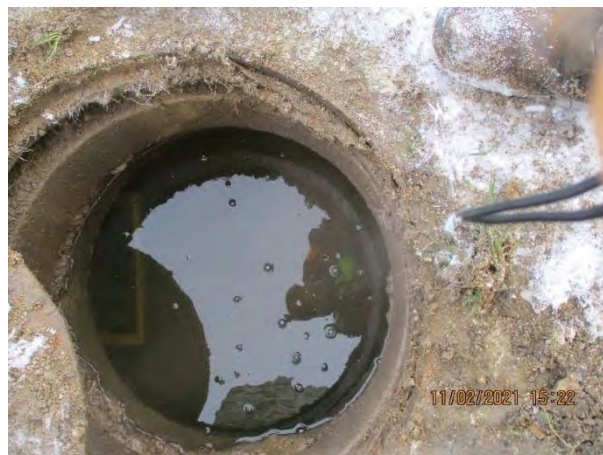
Figure 53 : Réseau EP en charge Rue de la Source (regard FLB-EP-290)
