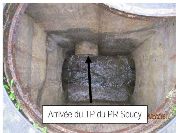
Figure 54 : Vue de l'arrivée du trop-plein dans le regard FLB-EP-55
