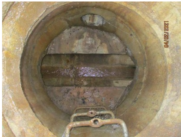
Figure 46 : Cunette perforée (regard FLB-EP-168, Rue des Clais)
