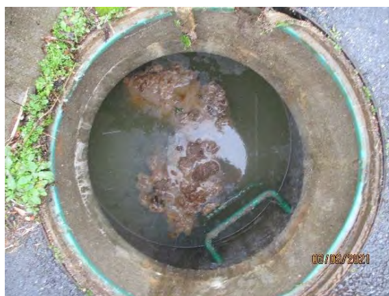
Figure 40 : Traces de mise en charge (regard FLB-EU-208, Place du Cèdre du Liban)
