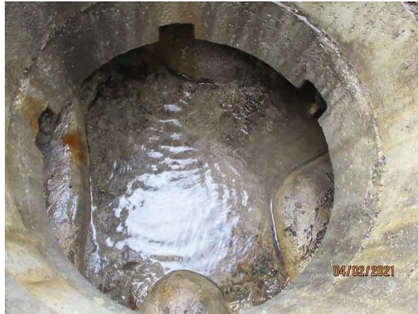
Figure 45 : Ecoulement par temps sec et infiltration en cheminée (regard FLB-EP-199, Rue des Eoliennes)
