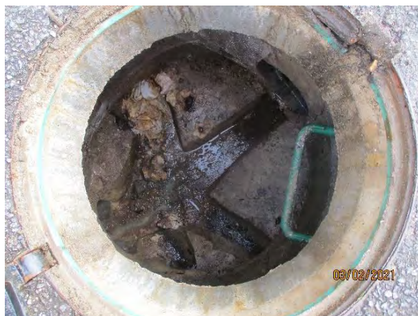
Figure 49 : EU dans EP (regard FLB-EP-141, Rue de la Belle Fontenay)
