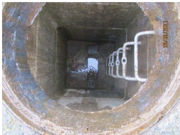
Figure 47 : Dépôt de gravats en cunette et écoulement lent (regard FLB-EP-006, Rue des Cheneaux)
