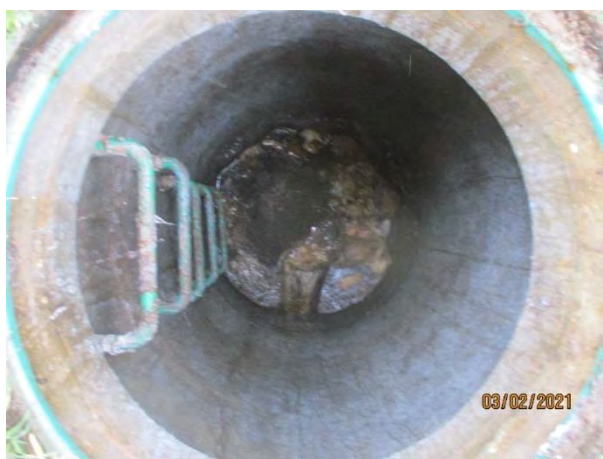
Figure 37 : Bouchon en cunette=50cm (regard FLB-EU-209, Place du Cèdre du Liban)
