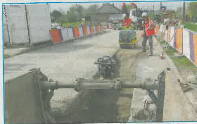
Les travaux ont commencé depuis janvier et se termineront en 2016. ©DR
